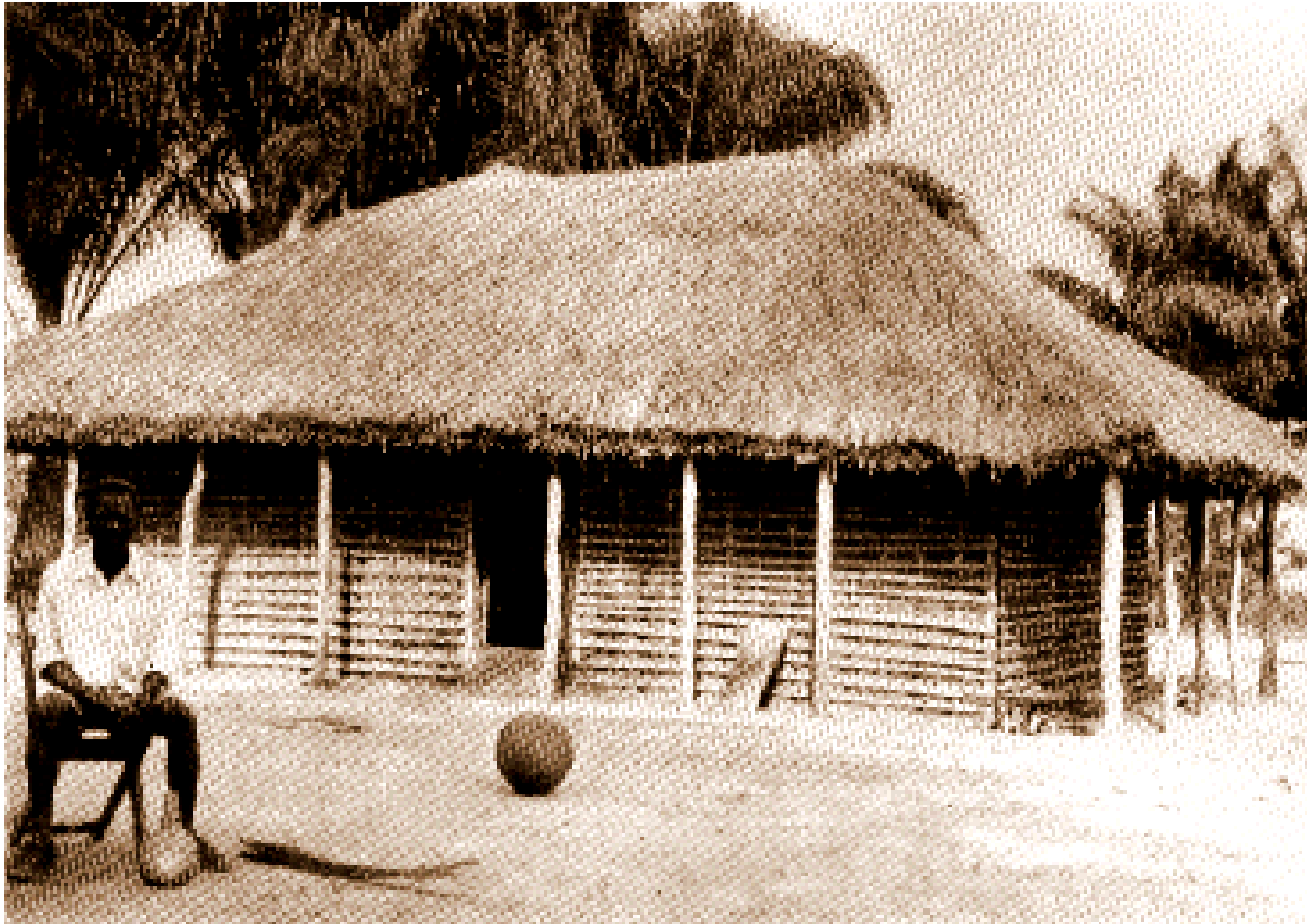
1. Aspect typique de la maison d'un chef de clan. Remarquez les murs remplis de terre mélangée à de l'argile. Le toit est en pisé."
